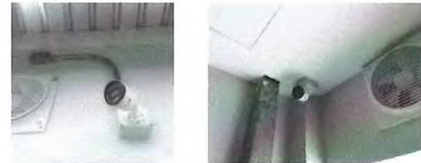
รูปที่ 34 การติดตั้งกล่องระบบ CCTV
