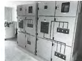
รูปที่ 18 ตู้ควบคุมไฟฟ้ากระแสสลับ SDB
